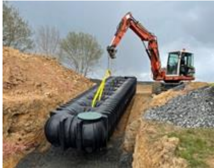
Die 25.000 Liter-Zisterne wurde eingegraben.
