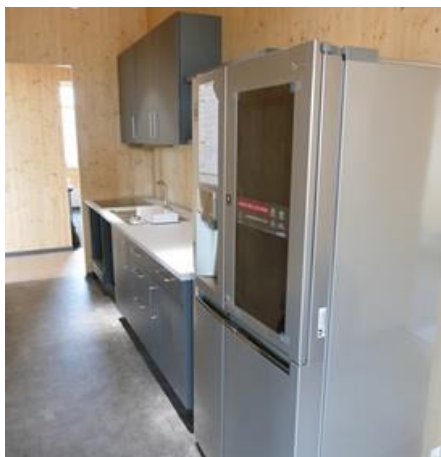
und die Küche wurde installiert.
